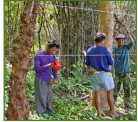
การร่วมมือกันของชาวบ้าน สลักพระ และเครือข่ายฯ เพื่อติดตั้งรั้วไฟฟ้าระหว่างป่าและหมู่บ้านที่ทำสวน
